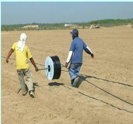
**Figura 81. Colocación de tuberías múltiples con conexión de laterales en la zanja**
