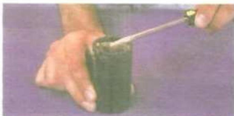
Enseguida, se descarga el condensador. Para ello se tocan los dos bornes con un destornillador que tenga un buen mango aislante, cuidando de asirlo solamente por el mismo. Si el condensador tiene carga, saltará un chispazo.
