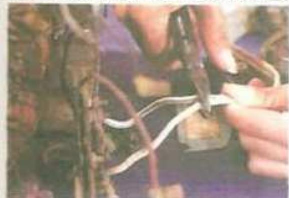
Al sacar la tapa con la placa de bornes se dibuja la manera en que está conectado cada cable, indicando el lugar de donde viene. Enseguida se pueden cortar los cables que van a la corriente.
