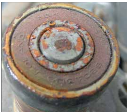
Fig. 5.02 - Oxidación de los rodamientos.
