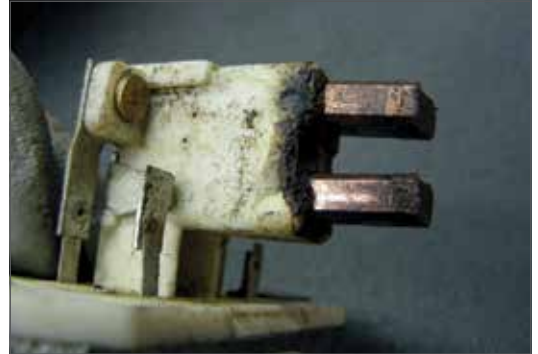
Fig. 3.03 - Escobillas y terminales del regulador de tensión quemados.
